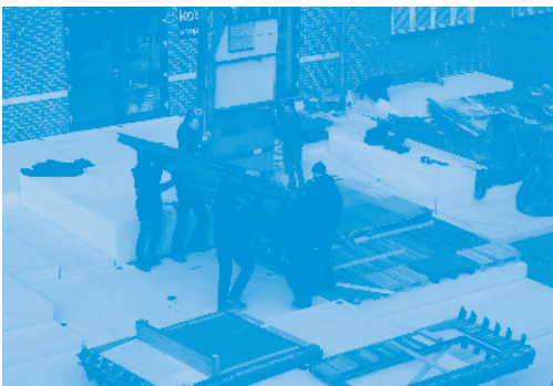
組み立ての様子(デンマーク、2016)
