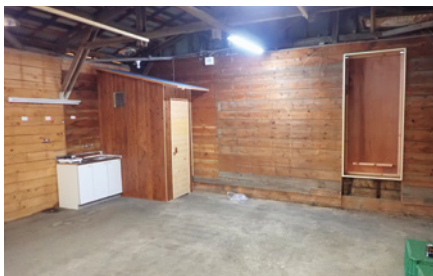
シンク・トイレ・出入口の扉を取り付けたばかりのスタジオ内
